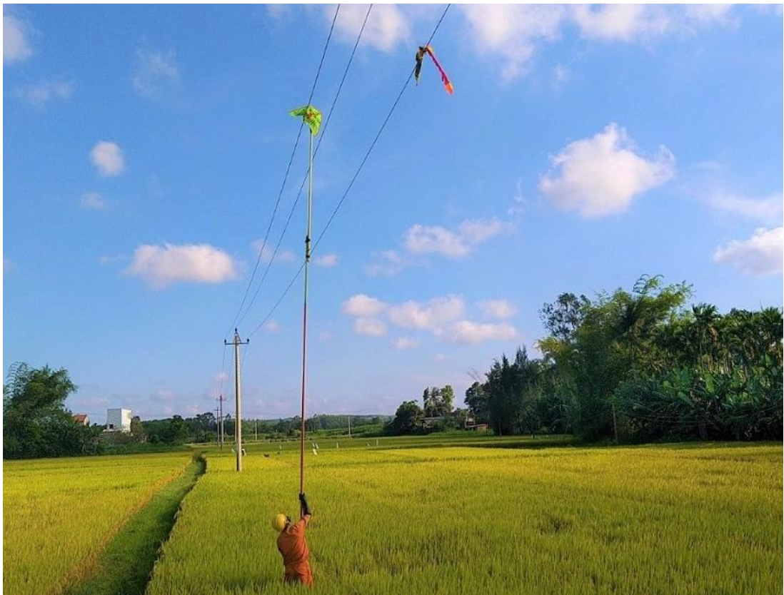
Hình ảnh: Điều chỉnh vào đường dây điện
